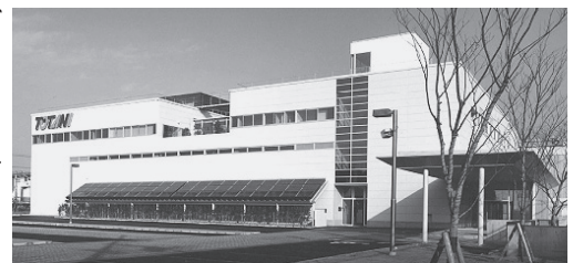
▲エコファクトリー&オフィスを実現した本社社屋
